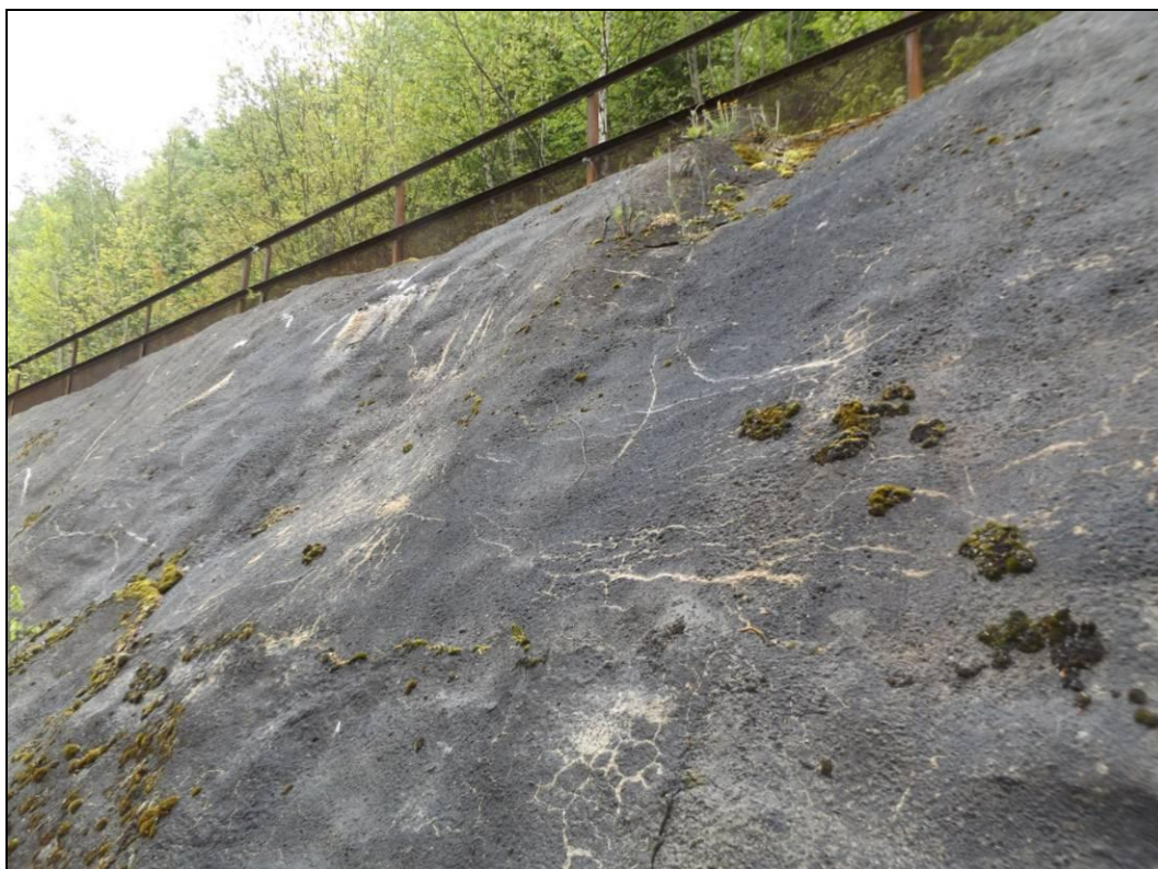
Obr. č. 8 – pohled na vlasové trhliny ZZ
